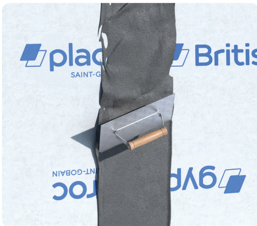
Figura 5: Tratamento de Juntas com Placoplast Basecoat.
